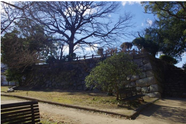
24 天守台東側より
