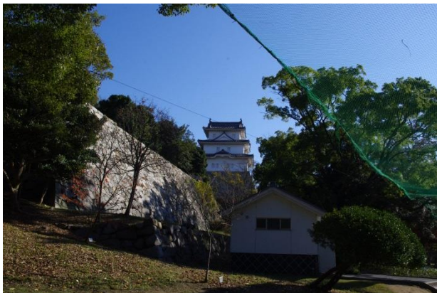
17 3号トイレ西側より
