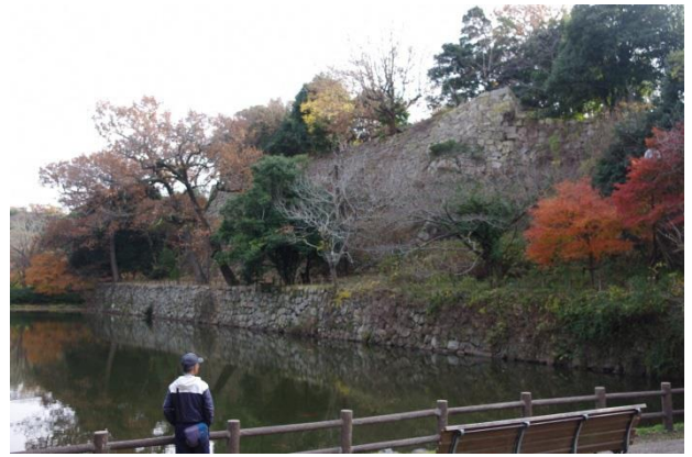
39 桜堀西側より
