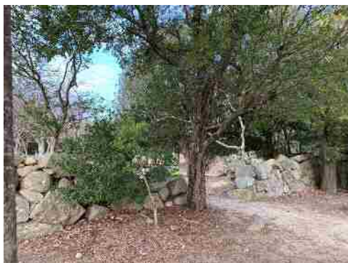
図 4-6 ③二ノ丸と東ノ丸の間の崩れた石垣
