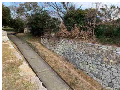
図 4-26 角の櫓から見た東帯曲輪
