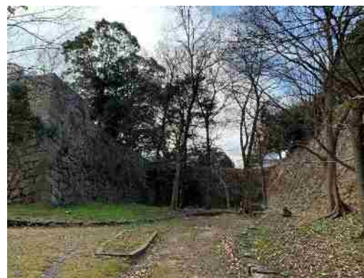
図 4-5 ②北側から見た本丸と二ノ丸の石垣
