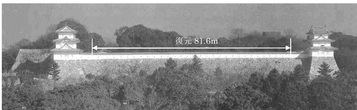
図4-48 巽櫓と坤櫓の間に復元された土塀
