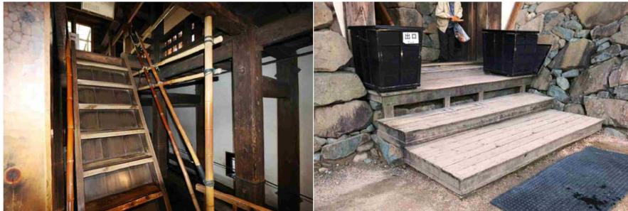
図9-1 松本城のバリアフリー化の事例（右：天守1階階段補助手摺、左：月見櫓出口段差補助） （「文化財の活用のためのバリアフリー化事例集」（文化庁文化財課））
