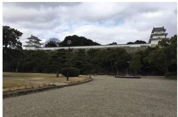
8 武蔵の庭園西側より
