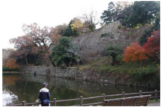
39 桜堀西側より
