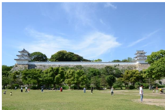
西芝生広場からみた櫓と石垣（樹木除伐・剪定後）
