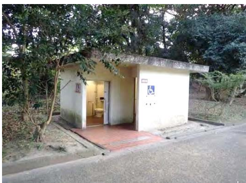
撤去・新設予定のトイレ
