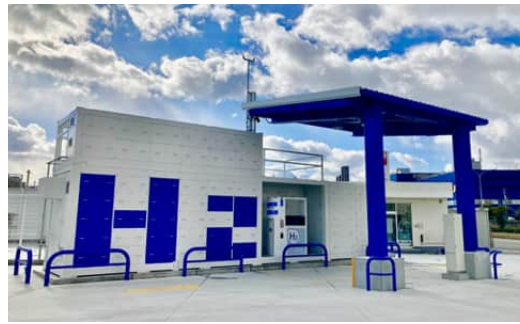
エア・リキード MK 神戸空港前水素ステーション(神戸市)
