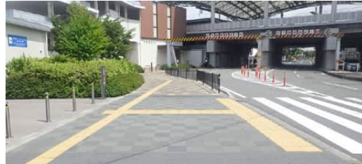
歩道のバリアフリー化(西宮市)
