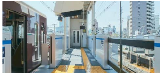
鉄道駅舎のエレベーター設置(神戸市)
