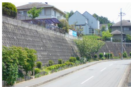
擁壁法尻部の緑化
