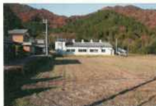
工場や事業所・倉庫等は、何も修景は行われていない。
