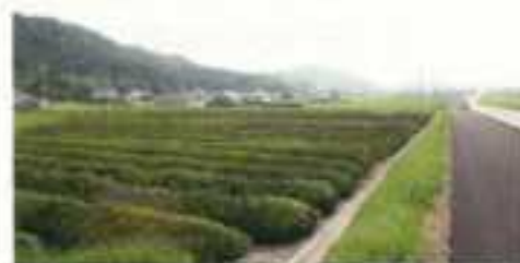
農地を東西に縦貫するバイパスの西脇篠山線
