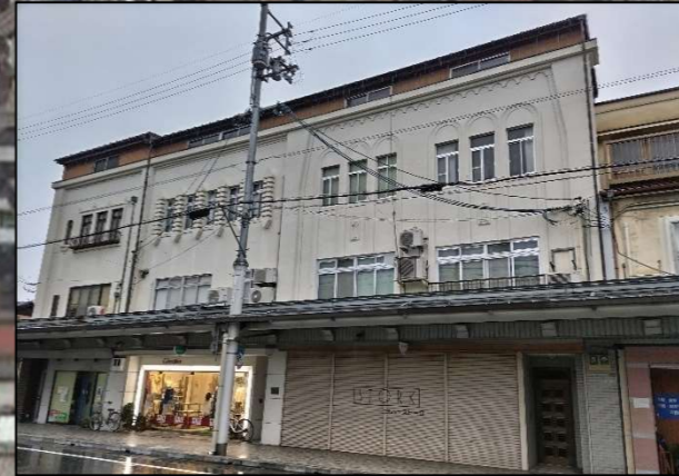
3連長屋 (登録文化財) 縦長の段窓と化粧柱を連窓で正面に配置する復興建築の共通したデザイン様式をもつ
