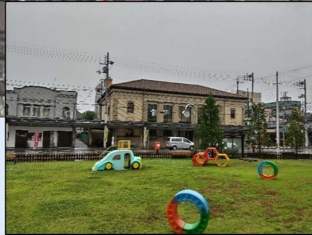
オーベルジュ豊岡1925 (登録文化財) 当初は銀行として建てられた。外壁はタイル張りで正面に壁柱を並べ、重厚な外観を持つ
