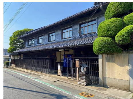
街道筋に建つ町家 (稲見酒造 (県景観形成重要建造物))
