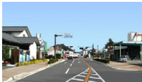
出典：下立杭柏原線道路景観検討業務報告書
