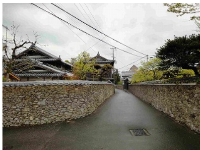
<ビューポイント> 上町公会堂北側の路地
