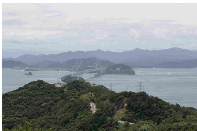
<ビューポイント> 大鳴門橋記念館の屋上展望台
