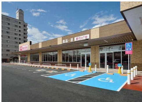
駐車中でも分かりやすいように区画面を着色した車いす用駐車場
