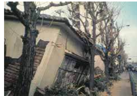
樹木が家屋の倒壊を支えた例 (出典：防災技術公園ハンドブック (財)都市緑化技術開発機構 公園緑地防災技術共同研究会編)
