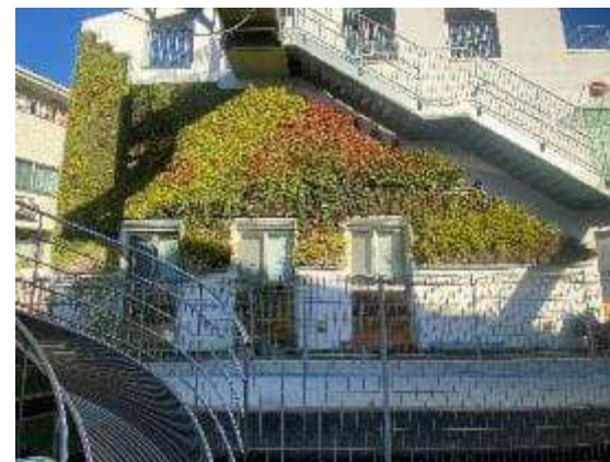
基盤造成型による壁面緑化 (明石市)
