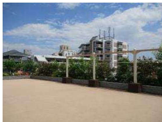
植栽による屋上緑化 (尼崎市)
