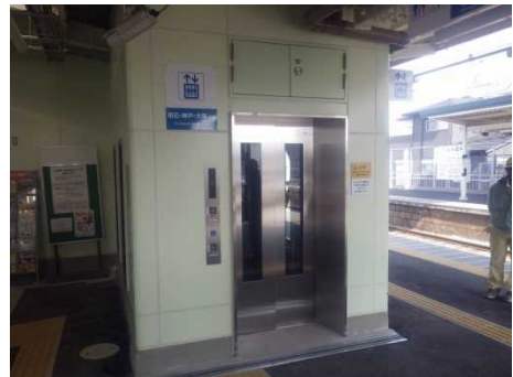
【鉄道駅舎へのエレベーター設置】
