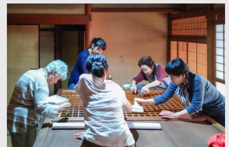
住民ボランティアによる建具の修繕 (淡河宿本陣跡保存会)
