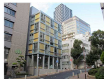
兵庫県林業会館（神戸市）
