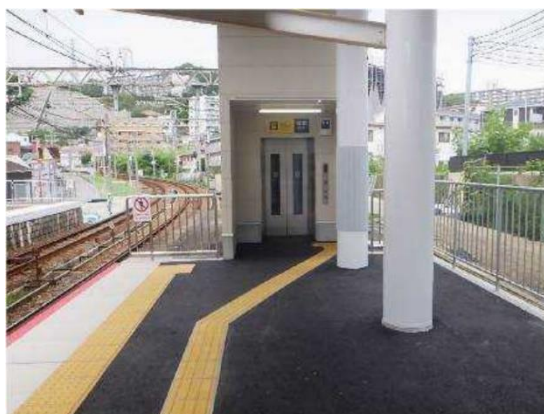
エレベータの設置
