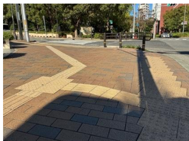
歩道の段差解消・ 点字ブロックの敷設
