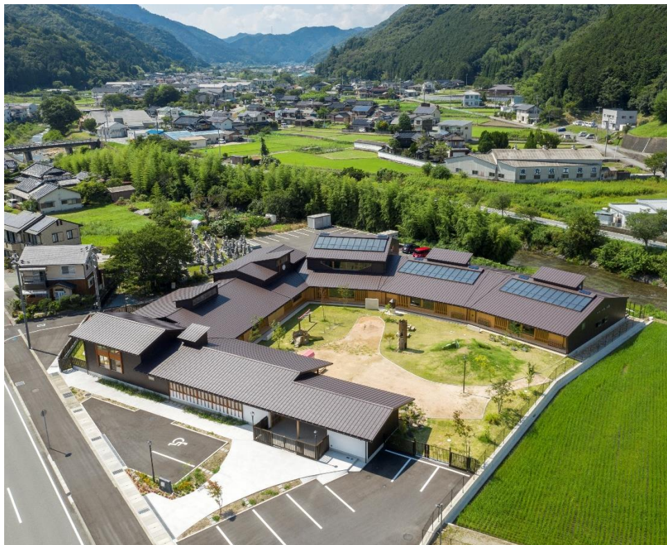
▲豊かな自然環境に溶け込む「C字」型の木造平屋の園舎
