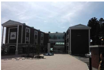
六甲山上遊休施設利活用支援制度の活用による高級ホテルの新築
