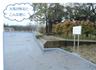
丹波年輪の里におけるグラウンドを調整池として活用した流域対策の実施
