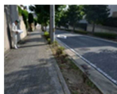
灌水不足による枯損
