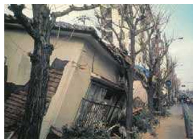
樹木が倒壊した家屋を支えた例 (出典：防災技術公園ハンドブック (財)都市緑化技術開発機構 公園緑地防災技術共同研究会編)
