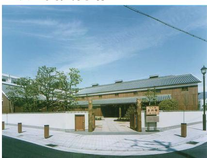
■阪神・淡路大震災により倒壊したが、50%以上の古材を再使用して、伝統工法に基づき、酒蔵の伝統的小屋組の重厚な雰囲気を忠実に復元した。
