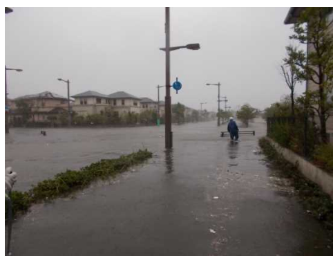
平成 30 年台風第 21 号浸水被害状況(南芦屋浜)
