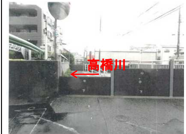
図21. 仮設の遮蔽板 設置例
