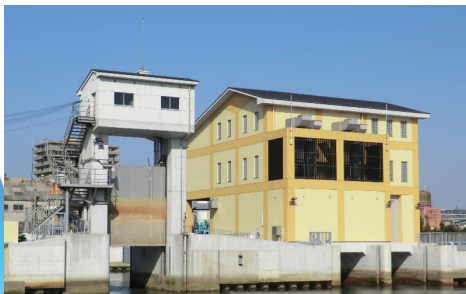
宮排水機場・水門
