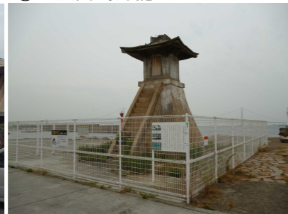
石積躯体と鉄筋コンクリート造の高さ 7.3m の灯籠。藩政時代から残る明石港のランドマーク
