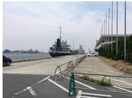
飾磨岸壁 (2 号岸壁より撮影)
