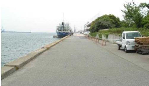
飾磨岸壁 (1 号岸壁より撮影)
