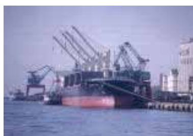
港湾機能充実の事例（姫路港大水深岸壁）
