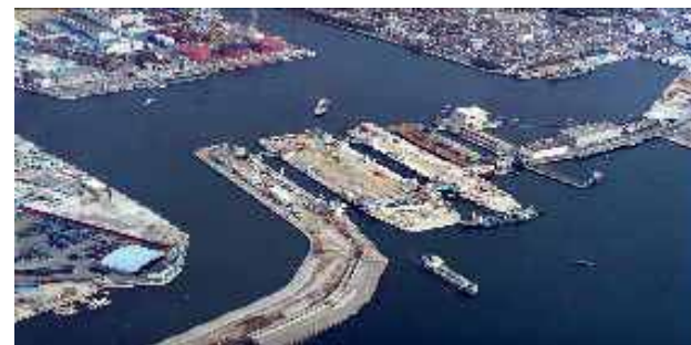
改良の進む尼崎閘門
