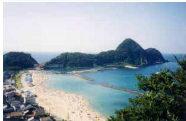
離岸堤等の設置による砂浜の復元(平成7年撮影)
