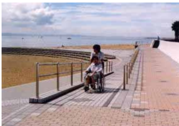
整備後 高齢者・身障者等の利用に配慮したスロープ
