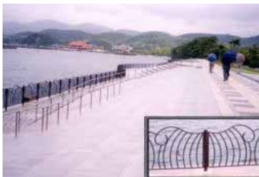
整備後のペーロン護岸(平成10年4月撮影)
