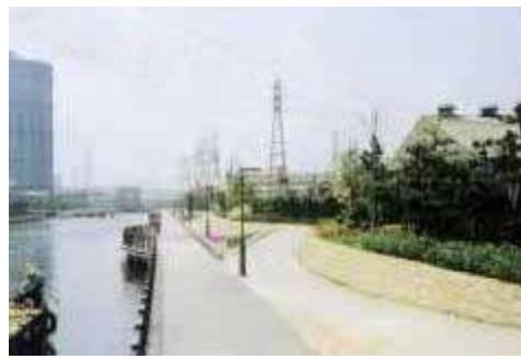
整備後(平成8年5月撮影)
