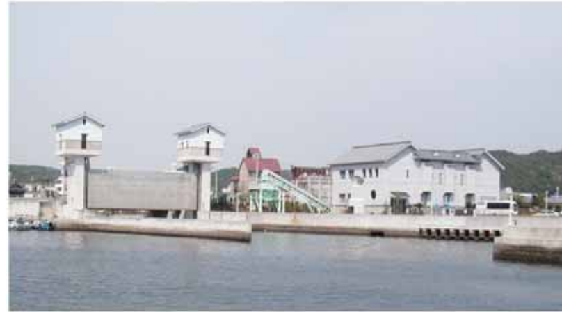
福良第2排水機場と水門
