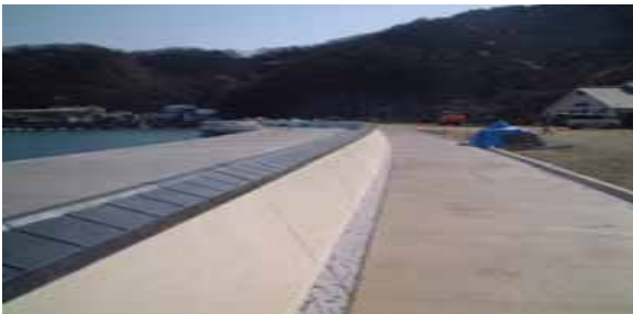
整備中の坂越港海岸整備事業 (赤穂市)
