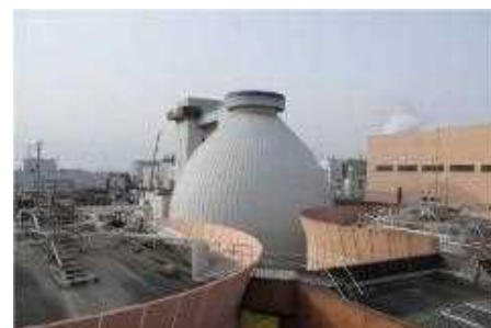
下水汚泥消化施設 （原田処理場）
