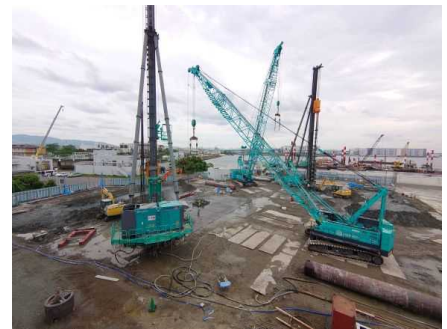
基礎工事 施工状況
