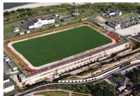
処理場上部空間を利用した多目的広場 （加古川上流浄化センター）
