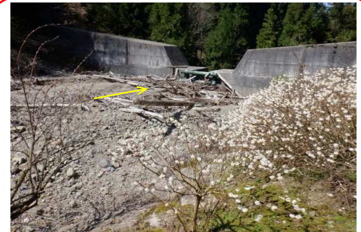
土石流発生直後
