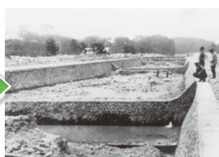
流路工施工後の 昭和初期の逆瀬川
