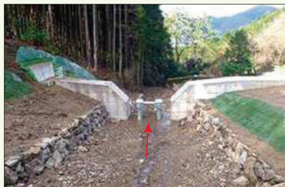
治山ダム(養父市養父市場)
