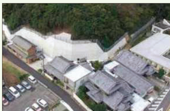
がけ崩れ対策(洲本市五色町鮎原西 鮎原西地区)
