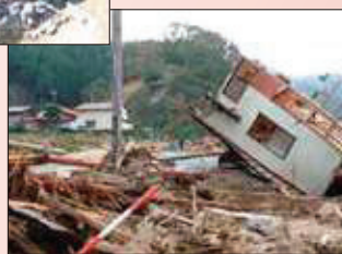
土石流による被害状況(豊岡市但東町)
