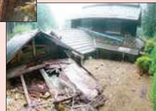
土石流による被害状況(朝来市佐囊)
