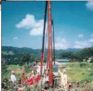
杭工 (新温泉町飯野地区)
