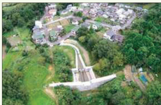
砂防堰堤(川辺郡猪名川町林田 南山谷川)
