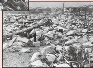
土砂で埋まった都賀川(神戸市灘区)
