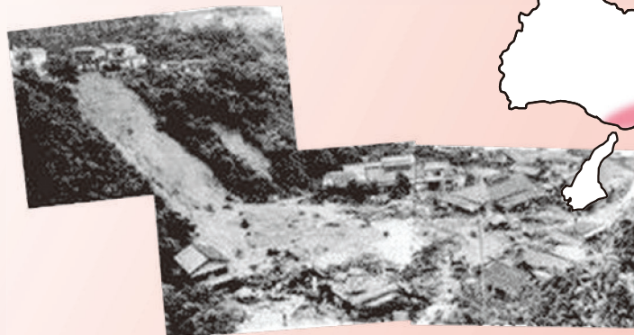
がけ崩れにより倒壊した家屋(神戸市長田区明泉寺町)
