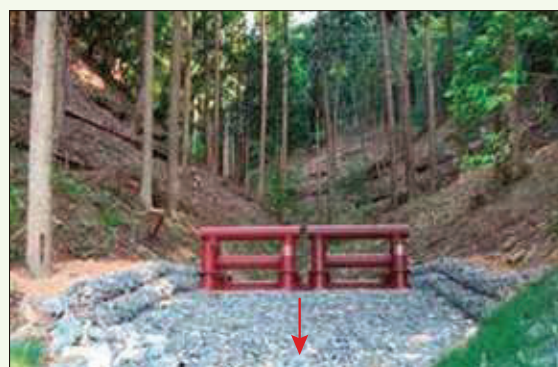
緊急防災林整備(養父市大屋町)
