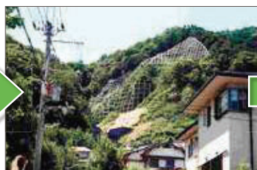
工事完了直後
