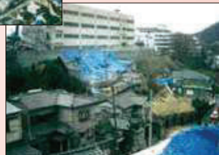
がけ崩れによる被害状況(神戸市長田区大丸町)
