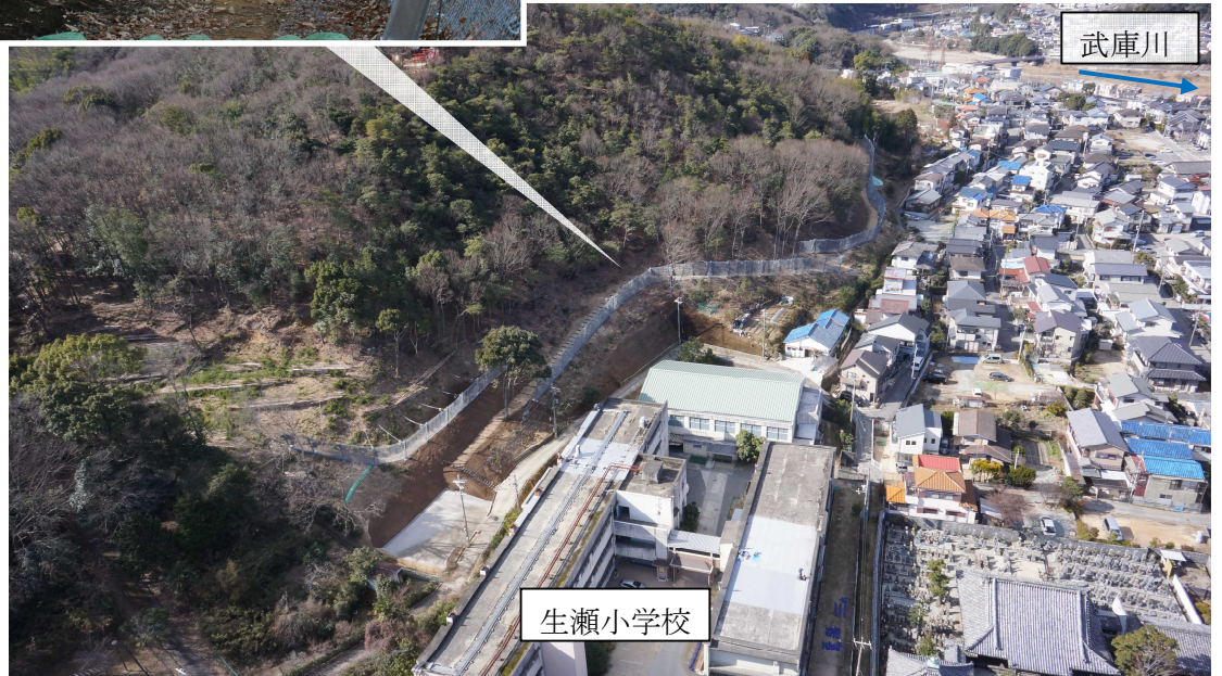
[平成 24 年度] 山林を保全し、山裾部で崩壊土砂を受け止める斜面对策
