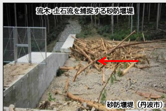
流木・土石流を捕捉する砂防堰堤
