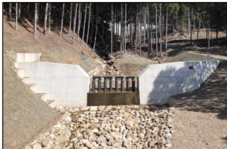
流木捕捉型治山ダム（丹波市）
