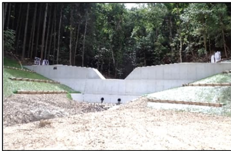
流木・土砂流出防止対策（加西市）
