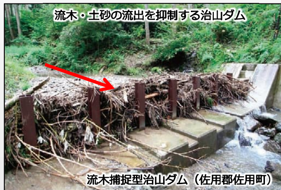
流木・土石流を捕捉する砂防堰堤
