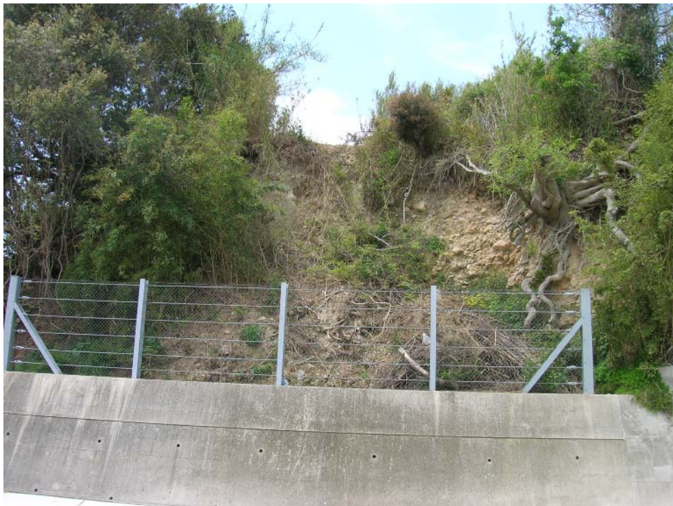
洲本市福良(2)地区 平成 16 年 10 月。台風 23 号に伴う斜面崩壊発生。
