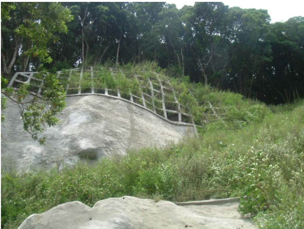
洲本市炬口地区 復旧後の状況。法枠を施工し、斜面を保護している。
