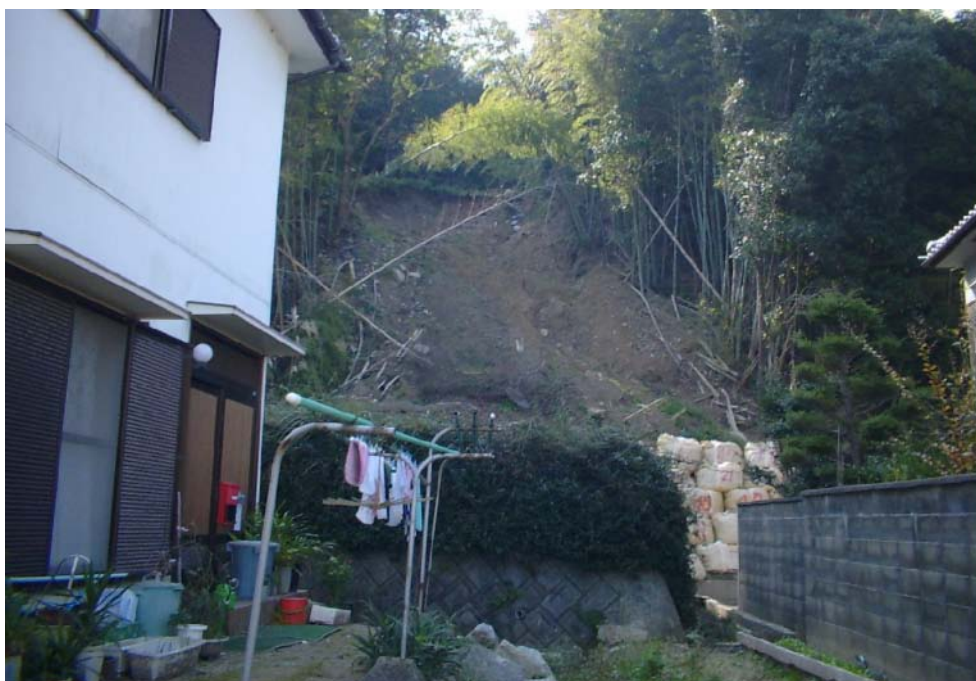
洲本市物部(2)地区 平成 16 年 10 月。台風 23 号に伴う斜面崩壊発生
