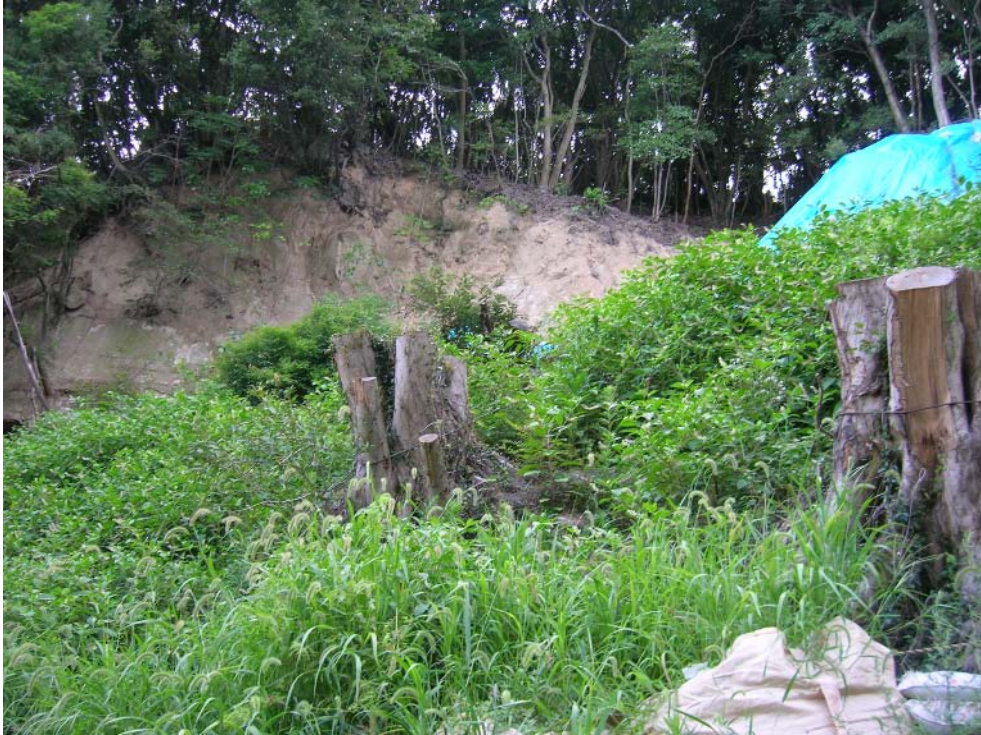
洲本市炬口地区 平成 16 年 10 月。台風 23 号に伴う斜面崩壊発生
