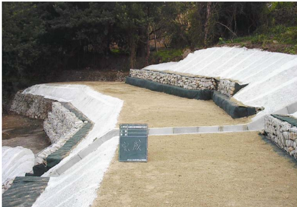
南あわじ市灘城方(2)地区 復旧後の状況
