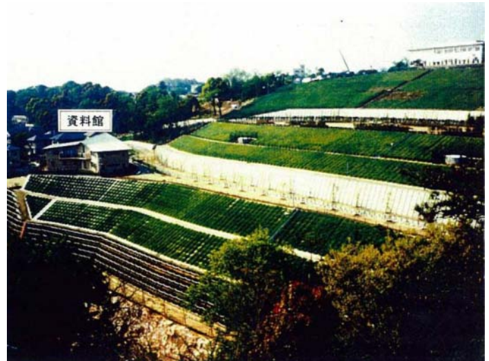
復旧後の状況(平成9年4月)
