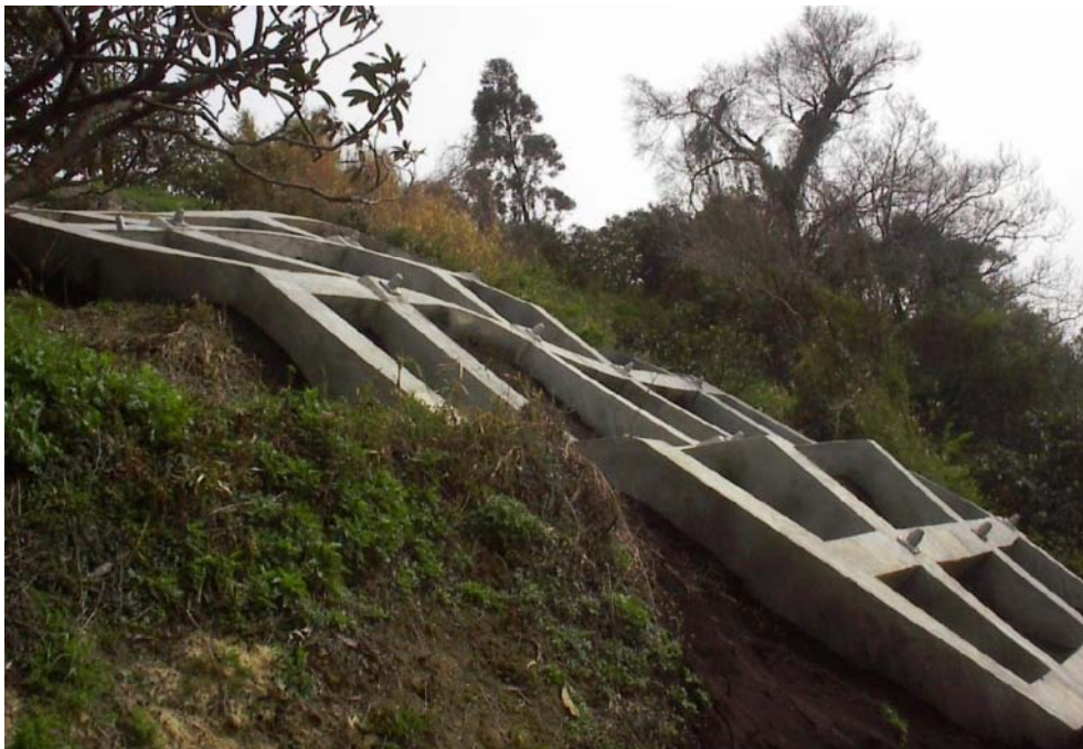
淡路市野島轟木地区 法枠工とアンカー工
