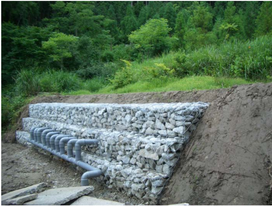
美方郡香美町村岡区丸味地区 横ボーリング工
