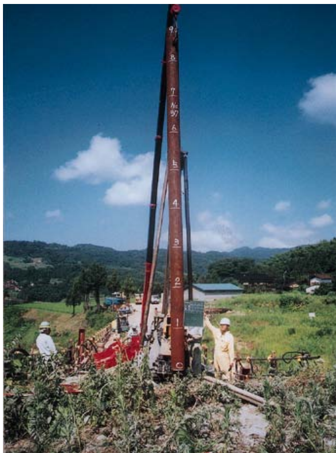
新温泉町飯野地区 杭工の施工状況
