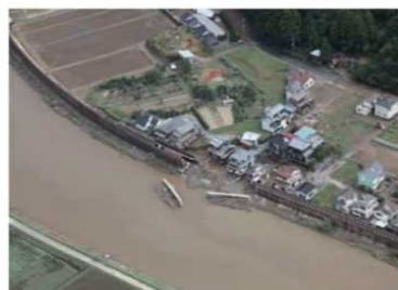
平成23年台風12号 熊野川高岡地区の輪中堤の倒壊
