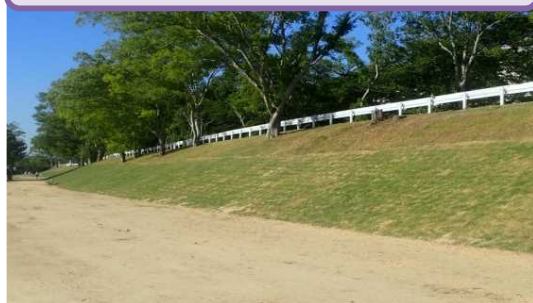
下流部築堤区間(堤防強化実施箇所)
