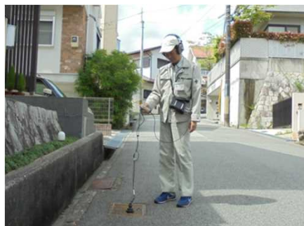
漏水調査状況 (宝塚市)
