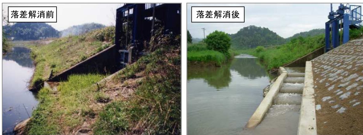
樋門の落差解消
