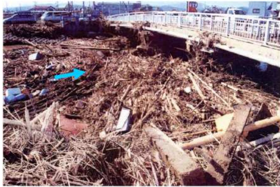
【平成 16 年台風 23 号時の流木等による閉塞状況 六方川梶原橋】
