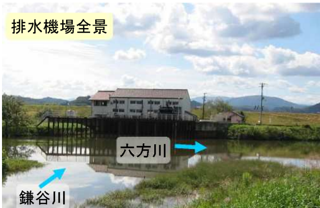
【六方川排水機場全景】
