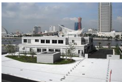
京橋ポンプ場(神戸市)
