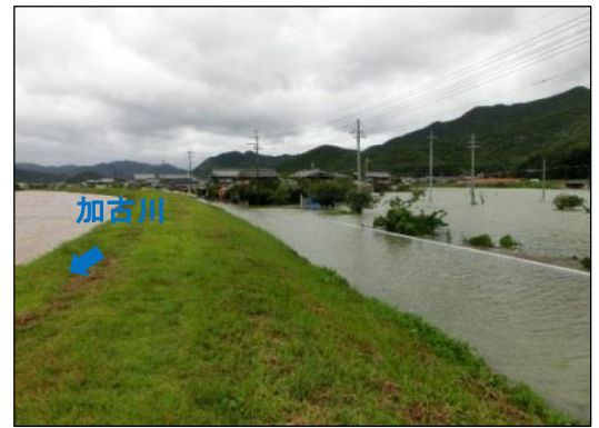
平成25年台風18号の浸水状況
