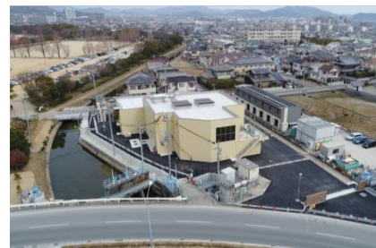
間の川ポンプ場(高砂市)
