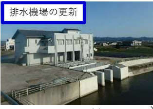
孫太川排水機場（南あわじ市）
