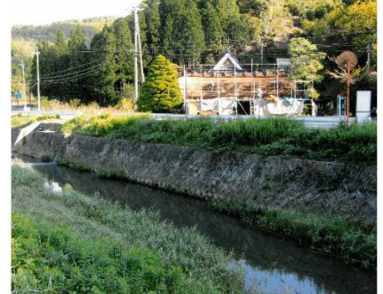
「かやぶき屋根の工事中」
