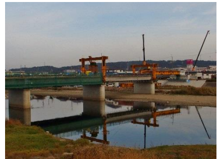
「かじや橋新設工事」(美の川)
