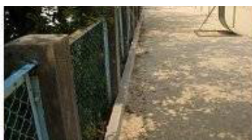
周囲に流出防止壁を設置
