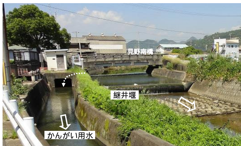
写真 12 継井堰の状況
