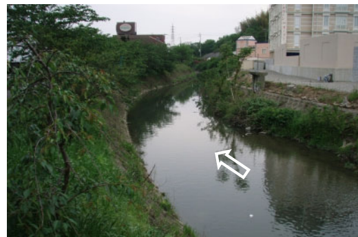
写真 15 継橋上流の状況
