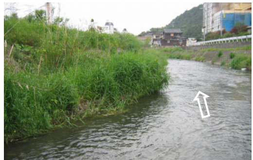
写真 16 継井堰下流の状況
