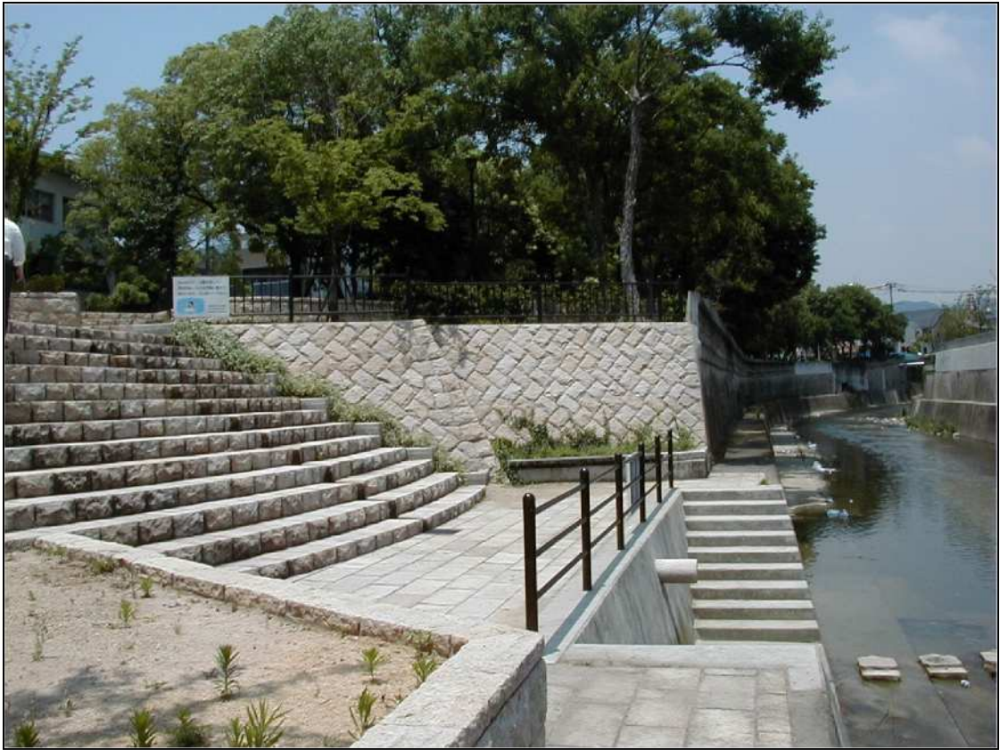
図ー2.1.6 親水施設事例（長田区役所上流）
