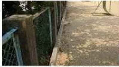
周囲に流出防止壁を設置
