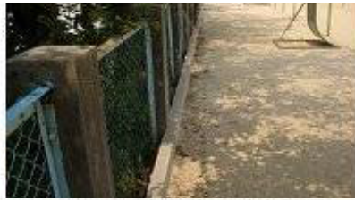
周囲に流出防止壁を設置
