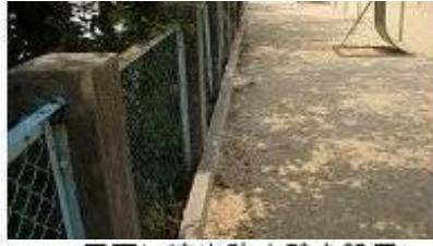
周囲に流出防止壁を設置
